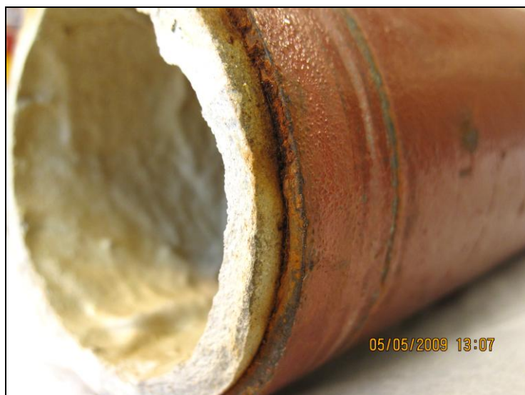
Fig 5.4 Prøve II med korrosjon
