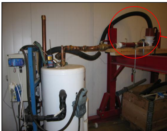
Fig 3.1 Oversikt over testrigg under montering
